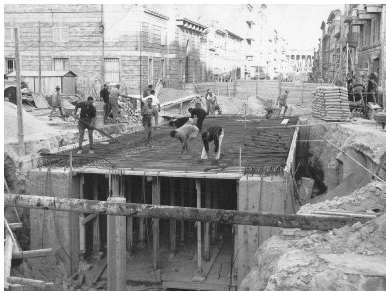
Costruzione sottopassaggio Piazza Garibaldi Macerata - 1960 - Biblioteca Statale Macerata - Fondo Balelli
