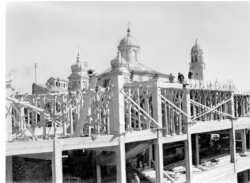
Costruzione della nuova sede della Cassa di Risparmio di Macerata
