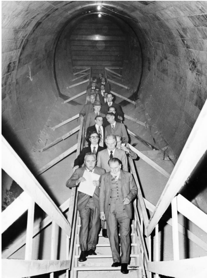
Il Ministro Aldo Bozzi visita un cantiere della Metropolitana di Roma
