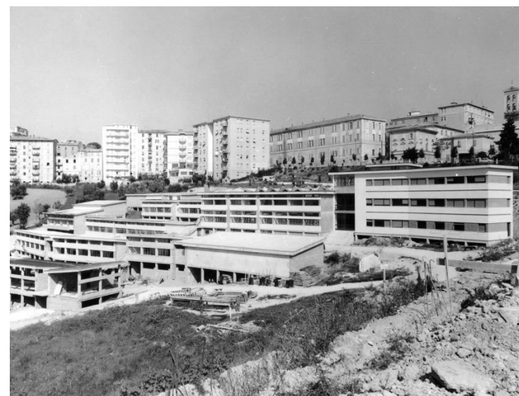
Costruzione della Scuola d'Arte La città si estende verso la campagna - Macerata - 1962 Archivio fotografico della Biblioteca Comunale Mozzi Borgetti di Macerata
