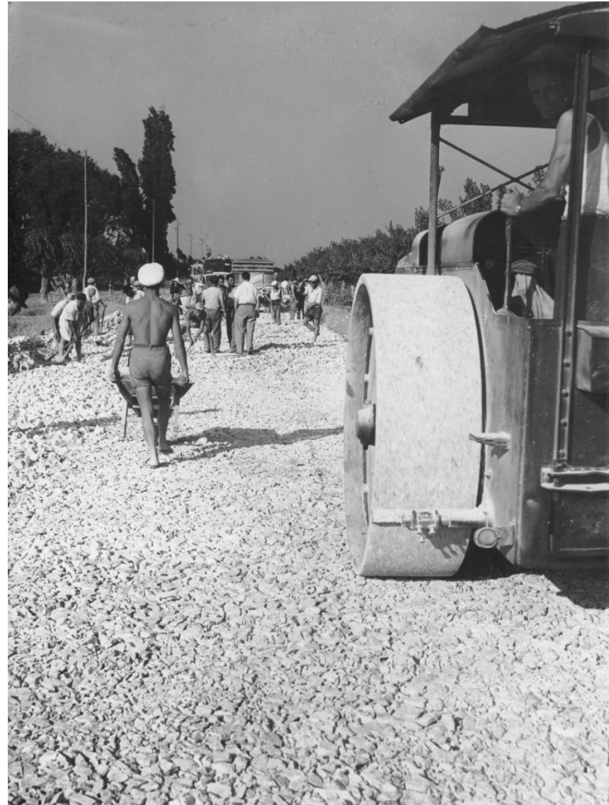
Asfaltatura Strada Regina
